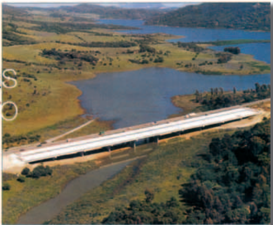
EN OBRAS. Viaducto en ejecución, sobre el pantano "Charco Redondo", en el municipio de Los Barrios.
